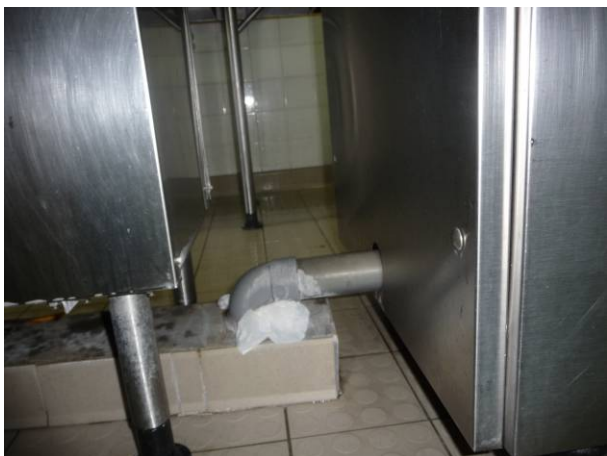
Vidange dans plot maçonné
