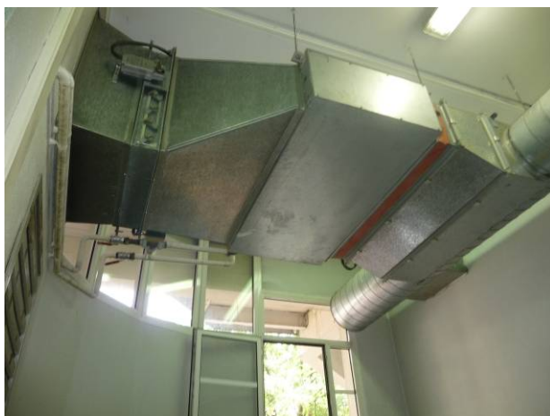
Volet de surpression sous la CTA
